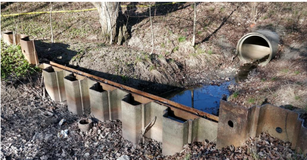
Figur 10. Exempel på utlopp med dämme. Foto: Sweco
