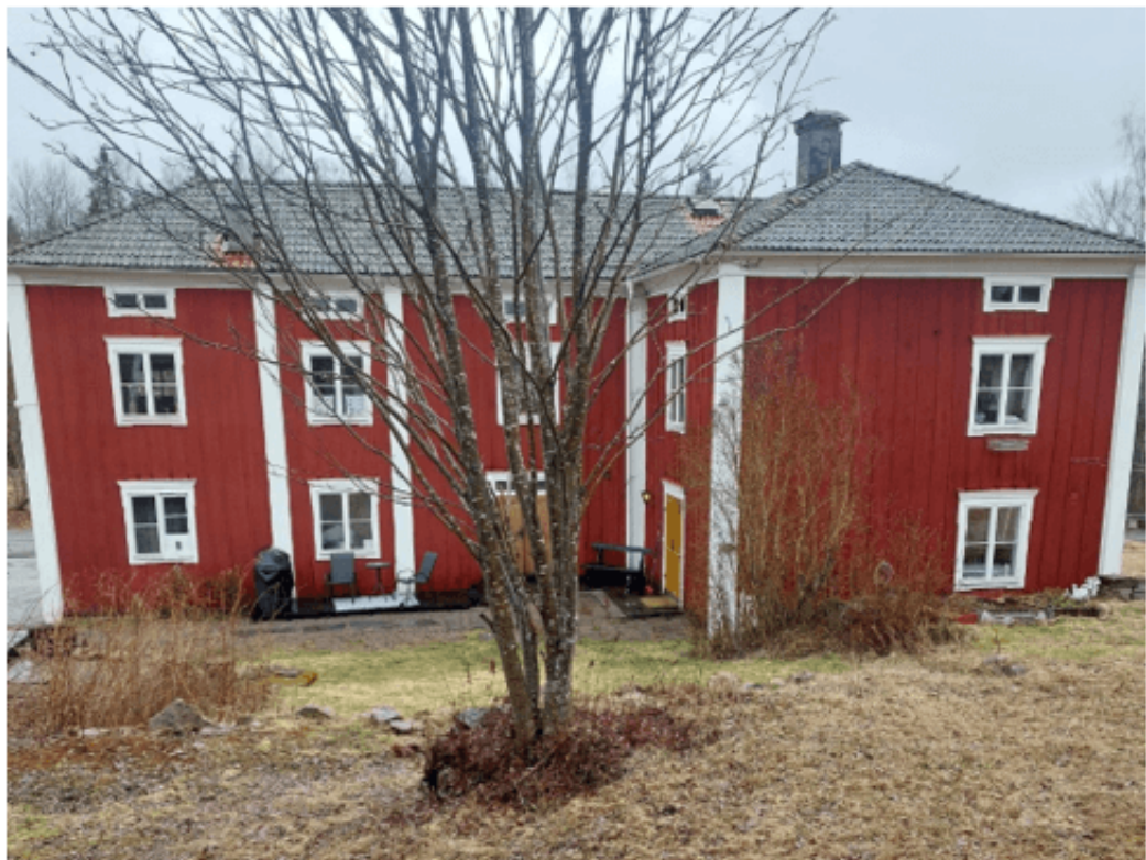
Figur 6: Huvudbyggnaden från innergården
