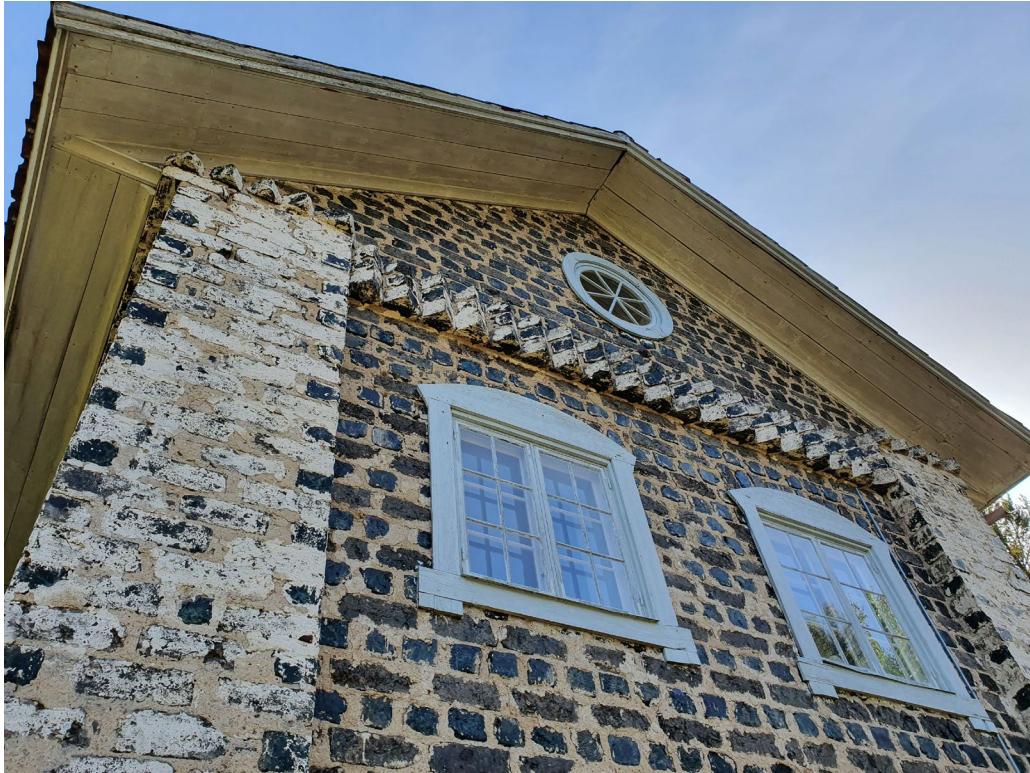
Figur 2: Detalj av gavelfasaden på kvarnen. Den rikligt artikulerade fasaden är murad i slaggsten. Foto Ovanåkers kommun
