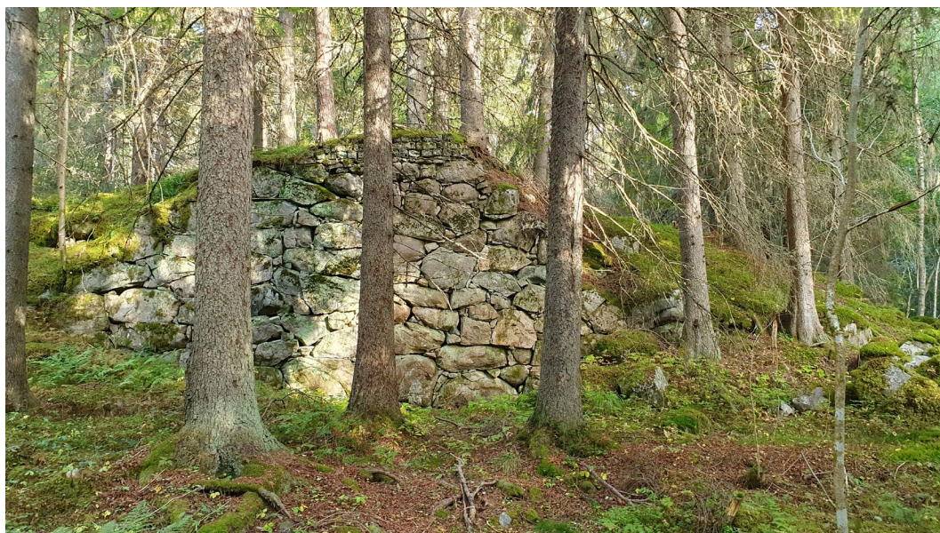
Figur 5: Del av dammkonstruktionen vid Övre hammaren. Foto Ovanåkers kommun
